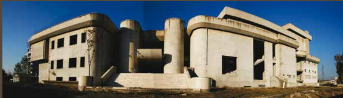
İnşaat halinde olan Yüreğir Kültür Merkezi
